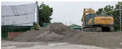
再生粒料（控制性低強度回填材料 CLSM）
