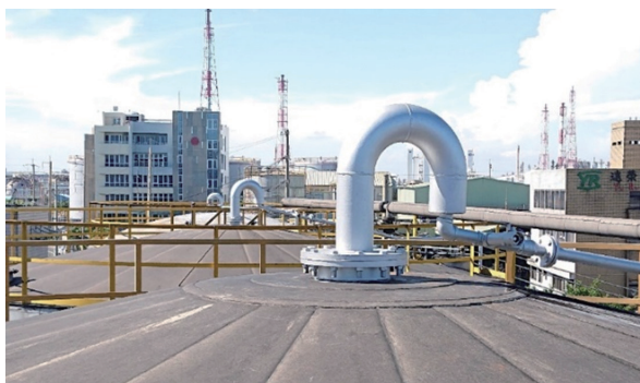
呼吸閥設置連接管
